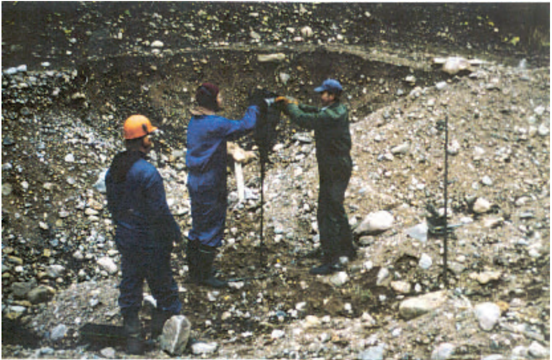
Kuva 4.1.2. Havaintoputkien asennusta kevyellä porakonekairauskalustolla. Kuva T. Kinnunen.
