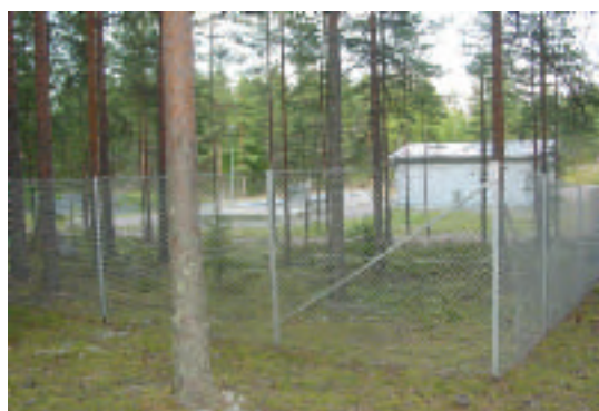
Kuva 4.2.2a. Nykyisen käytännön mukaisesti pohjavedenottamoiden vedenottoalueet yleensä aidataan. Kuva T. Kinnunen
