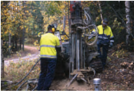
Kuva 4.3.1 d. Monikerrosnäytteenottoon soveltuvaa havaintoputkea rakennetaan reaktiivisten seinien tutkimusten yhteydessä Orivedellä. Kuva SYKE/S. Giles.
