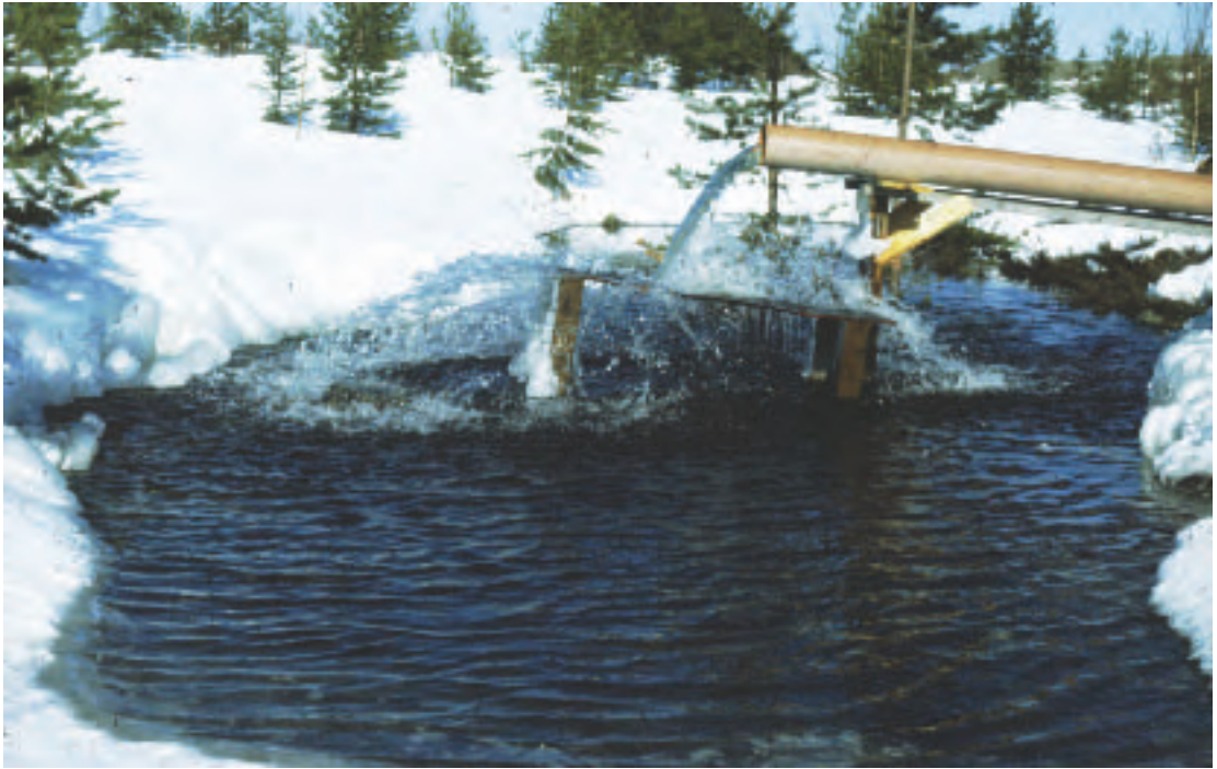
Kuva 4.1.3d. Kuva koepumppauksen poistoputken päästä. Pumppauspaikalta poisjohdettavat vesimäärät voivat olla suuria, minkä vuoksi purkuveden aiheuttamat haitalliset muutokset ympäristöön on estettävä. Kuvassa pumppausveden aiheuttaman eroosion estämiseksi tehty yksinkertainen rakennelma. Kuva E. Mälkki.
