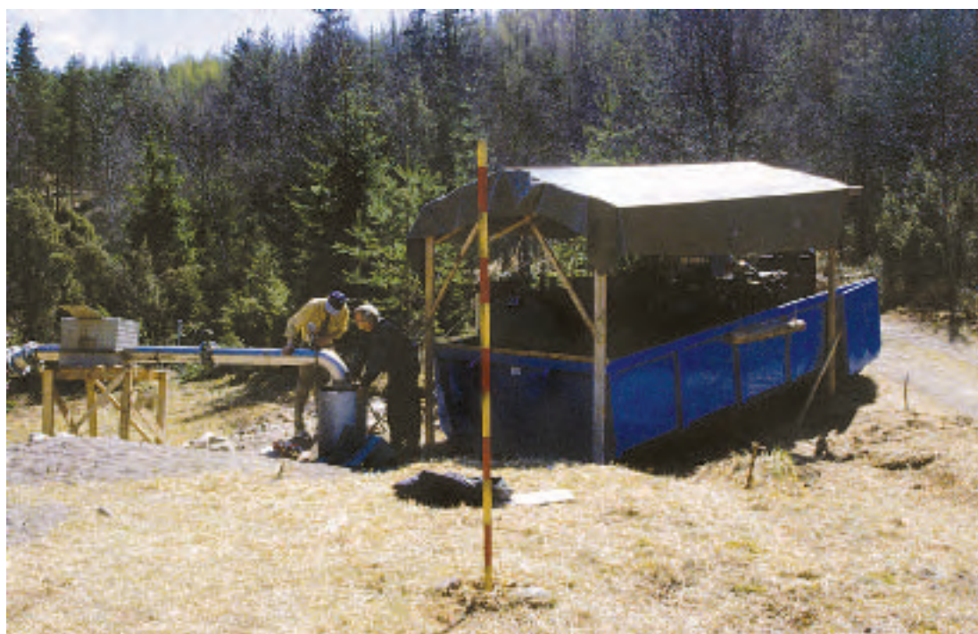
Kuva 4.1.3b. Uppopumpulla siiviläputkikaivosta tehtävän koepumppauksen käynnistys. Laitteiden tarvitsema sähköenergia tuotetaan diesel-aggregaatilla. Kuva T. Kinnunen.
