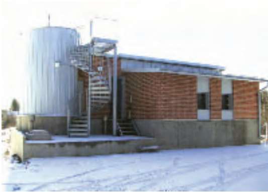
Kuva 6.7. I d. Paippisten pohjavesilaitos. Käsittelynä ilmastus, hiekkapikasuodatus ja UV-desinfiointi. Kuva U. Tantt.
