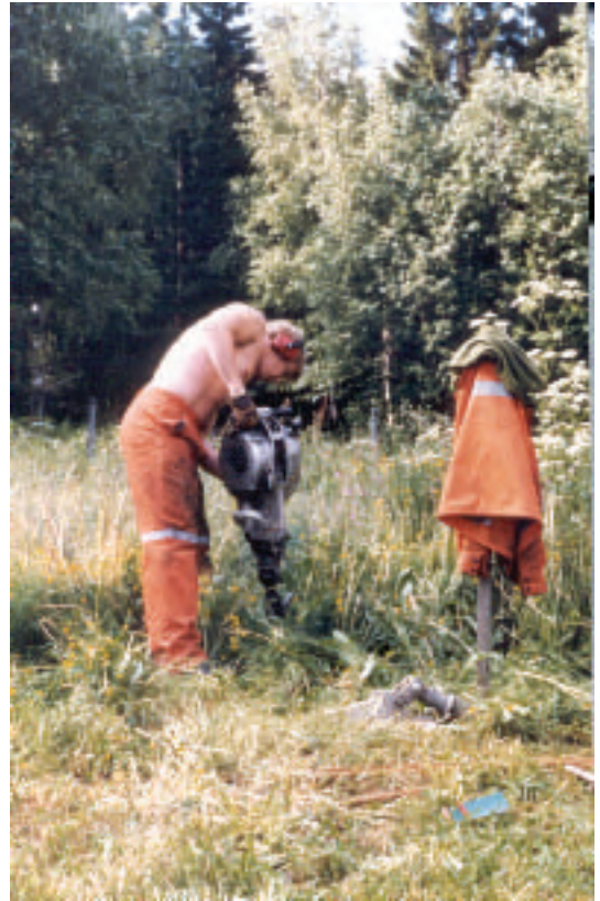
Kuva 5.2.5a. Tärykairaus kevyellä porakoneella. Kuva E. Mälkki.
