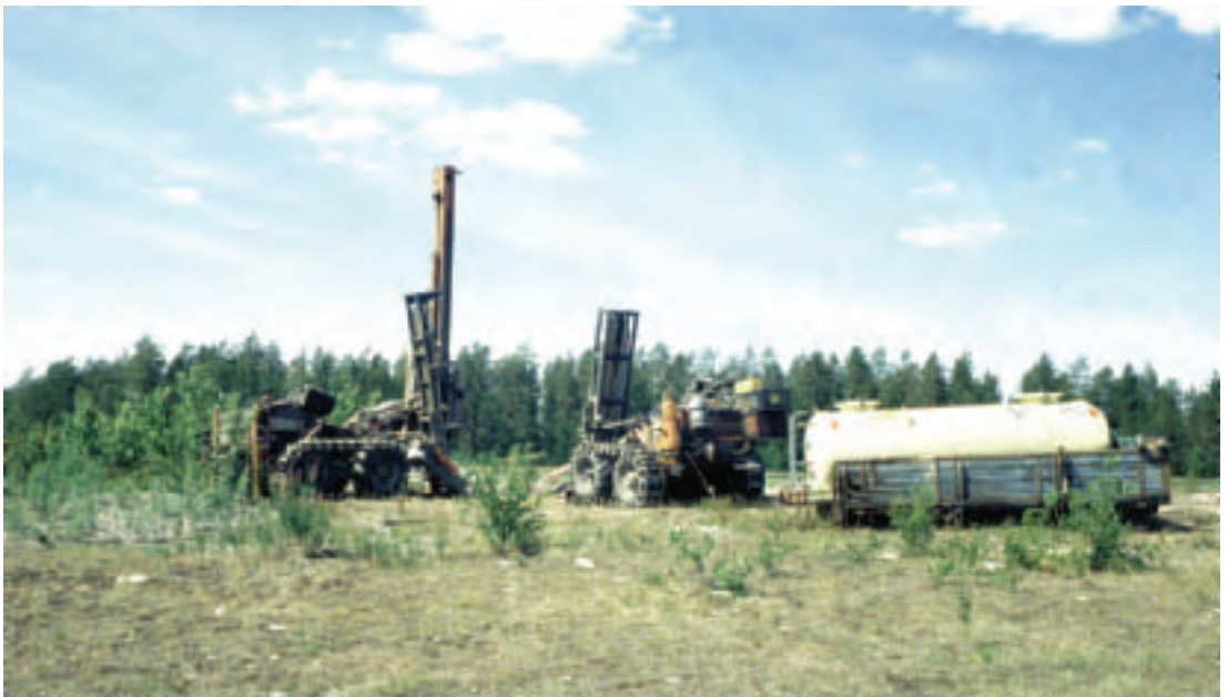
Kuva 5.2.5b. Esimerkkejä porakonekairauksiin käytettävästä kalustosta. Ylhäällä vasemmalla hydraulitoiminen keskiraskas tela-alustainen porakone, oikealla paineilmatoiminen raskas porakone ja alhaalla täyshydraulinen, tela-alustainen raskasporakone. Kuvat J. Arjas, Suunnittelukeskus Oy & T. Kinnunen.
