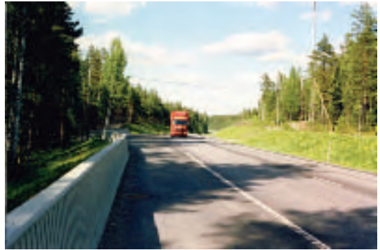
4.2.8. Pohjavesisuojaus Vihdin Nummelanharjulla. Vasemmalla säiliöauton kaatumisen estävä betonikaide, oikealla luiskasuojauksia. Kuva T. Kinnunen
